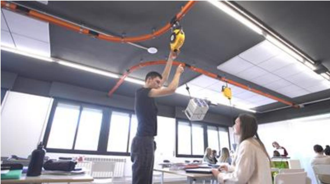
Abbildung 6.7: Frei bewegbare Steckdosen an der Decke (Ethazi Tknika, 2021)
