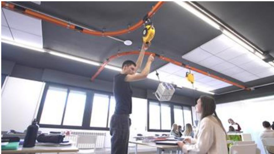
Abbildung 6.8: Freibewegbare Steckdosen an der Decke (Ethazi Tknika, 2021)
